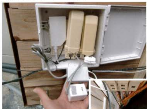
電話・インターネット等の 接続方法が、工具を使わず に着脱できること。
