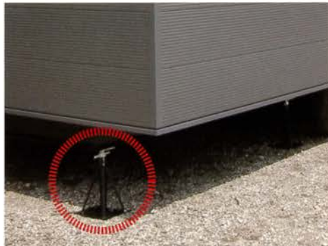
車輪以外の物で地盤上に支持されている場合 その支構造体の取り外しが工具を使わずにできること
