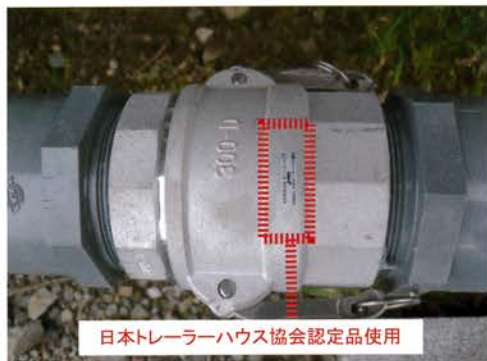
排水管の接続方法が工具を使わずに着脱できること。
