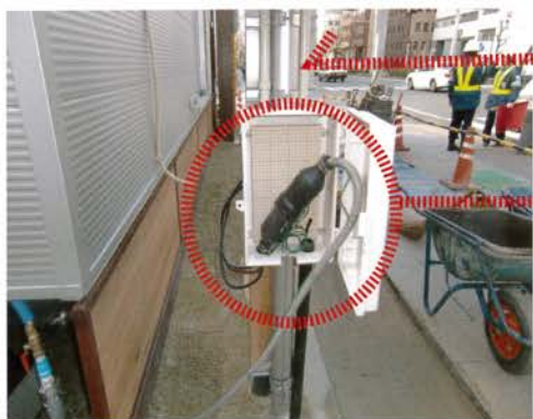
電気の配線方法が、工具を使わずに着脱できること。
