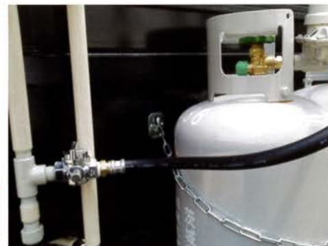
ガスボンベがトレーラーハウスに積載されているか 又はレンチで簡単に着脱できること。
