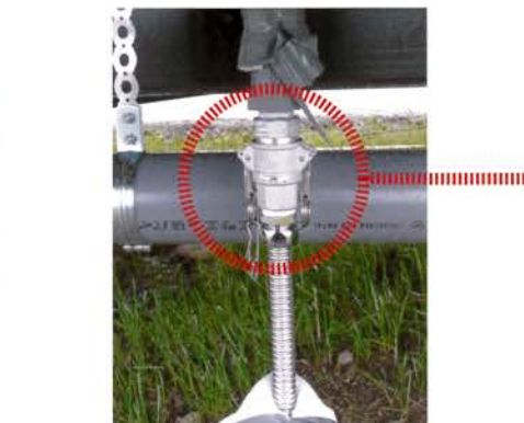
給水管の接続方法が、工具を使わずに着脱できること。
